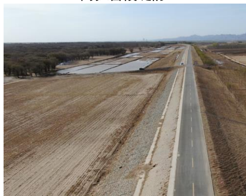
土右旗段堤防
