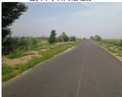
杭锦旗段堤防
